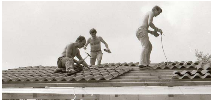
Dacharbeiten im Sommer 1982 v.l.: Holger Radeke, Peter Wagner und Hubert Adler
